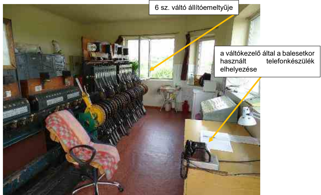
9. ábra: II. állítóközpont belső elrendezése
